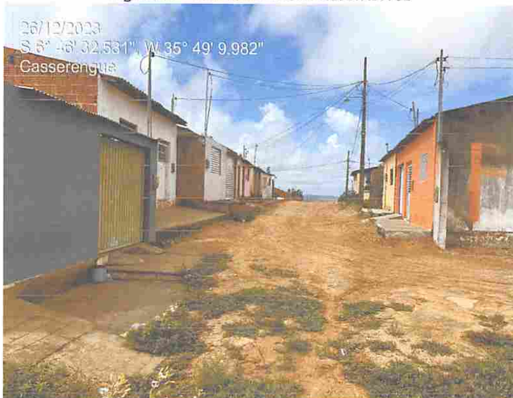
Figura 02 – VISTA 02 DA RUA PROJETADA 01
