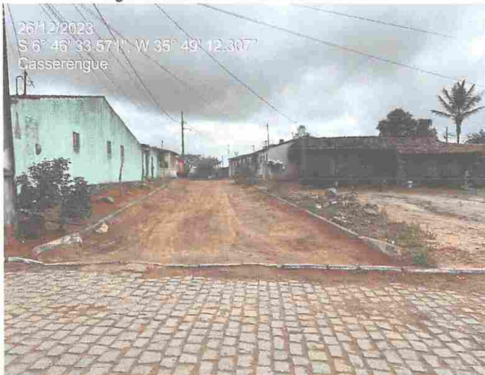
Figura 01 – VISTA 01 DA RUA PROJETADA 01
