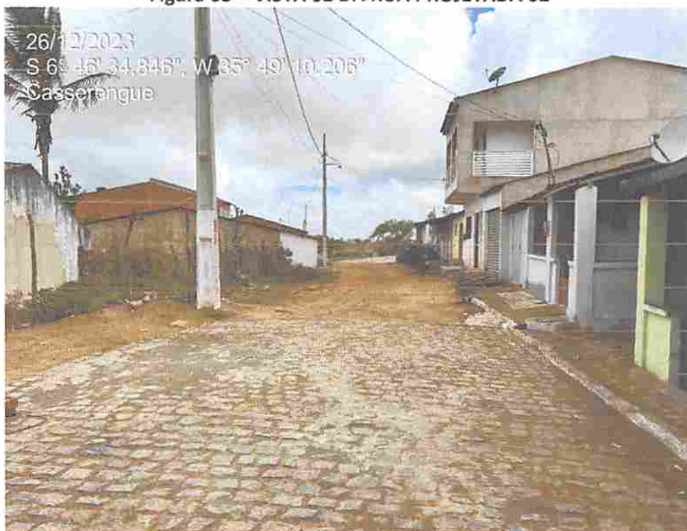
Figura 03 – VISTA 01 DA RUA PROJETADA 02
